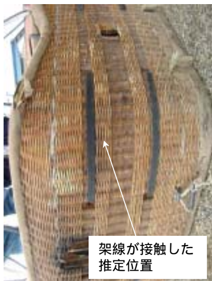
図3 架線接触部の外観
